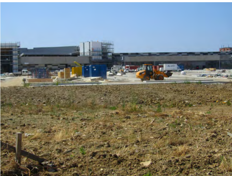
Il Parco Levante in costruzione, 22 luglio 2015.
